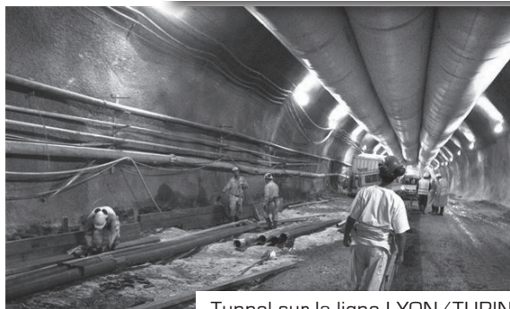
Tunnel sur la ligne LYON/TURIN
